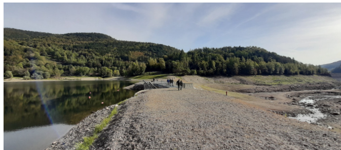
Figure 14 : digue submersible du barrage de Kruth-Wildenstein permettant de conserver un plan d'eau pour les activités touristiques – Image : TerraWater
